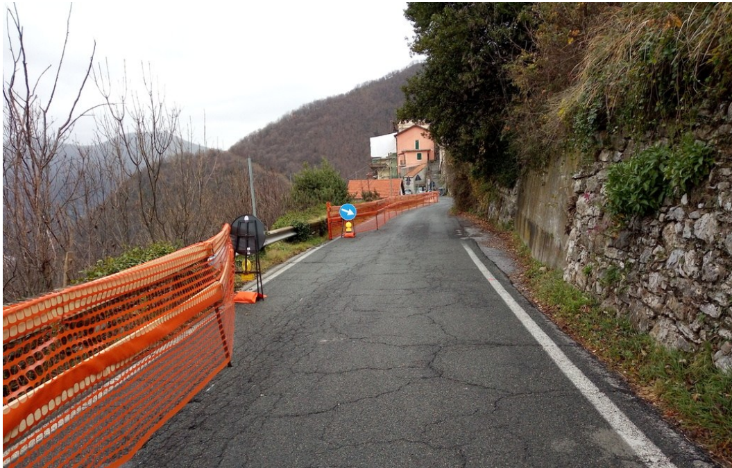
km 3+700 - 3+800 – intervento in programma: realizzazione cordolo in c.a. su micropali di consolidamento e installazione nuova barriera di sicurezza stradale.
